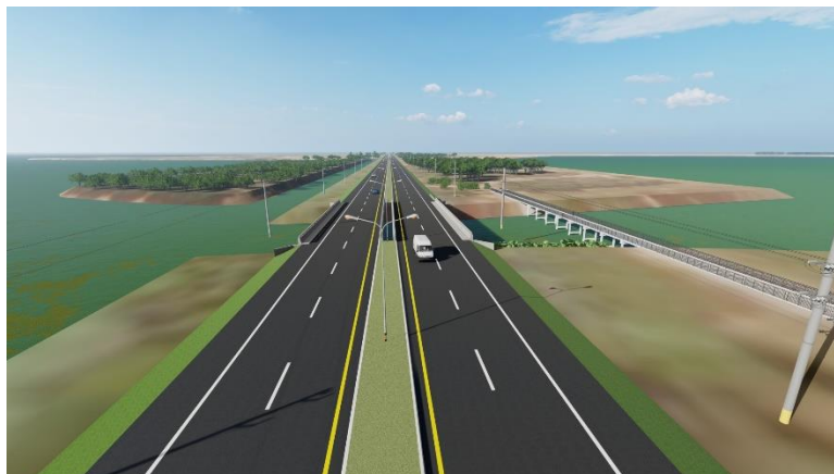
รูปที่ 4.4-3 รูปแบบเกาะกลางแบบเกาะยก (Raised Median) <<กลับไปยังสารบัญ บริเวณผ่านเขตห้ามล่าสัตว์ป่าอ่างเก็บน้ำห้วยตลาด ในแนวเส้นทาง
